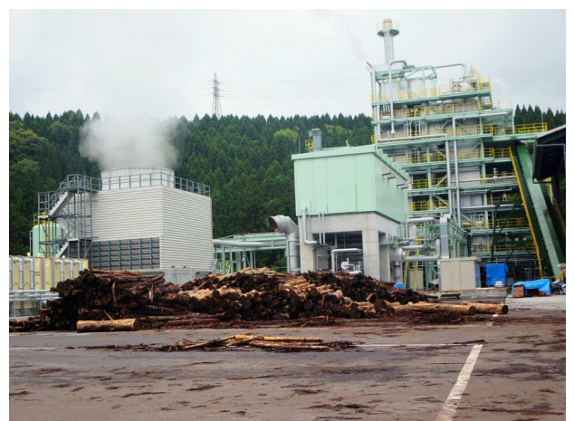
霧島バイオマス発電所
