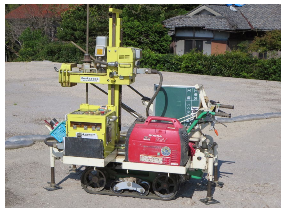
SWS 検査状況
