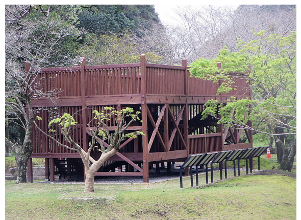
（岩屋公園に完成した展望デッキ）
