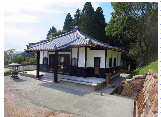
当社が施工した 南泉院本堂
